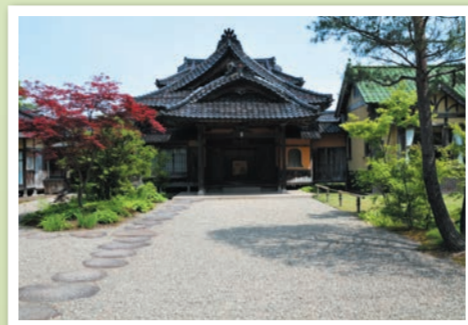
5 松籟閣 (重要文化財) 昭和初期、朝日酒造の創立者である平澤與之助が建てた住宅です。松籟とは松の梢を吹く風の音のこと。伝統的な日本家屋にアールデコ様式の丸窓やスタンドグラスなどの装飾を採り入れています。
